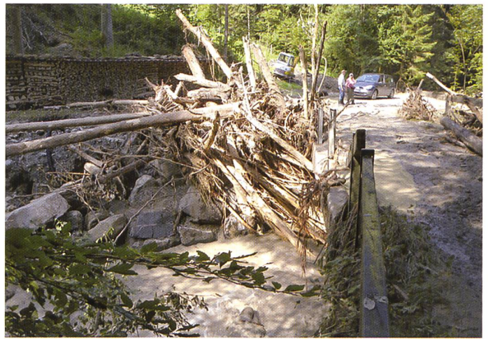
Bild 9. Teilverklauung am Widerlager einer Brücke am Auerbach. (Foto Bänziger Partner AG).
