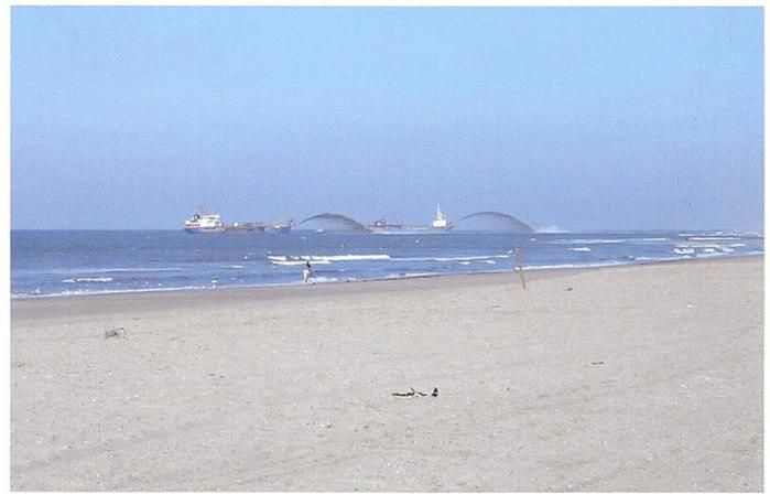
**Bild 26. Aufspritzen von Sand an der Küste.**
