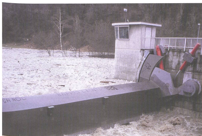
Bild 3. «Eistepich» oberhalb des geschlossenen Eiswehres.
