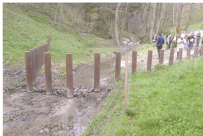
Bild 5. Holzfang am Holderbach oberhalb des Siedlungsgebietes in Zürich-Affoltern.
