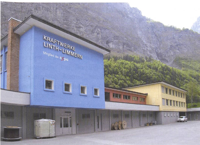
Kraftwerkszentrale Linth-Limmern in Linthal.
