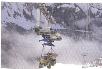
Bauseilbahn 1 nimmt den Betrieb auf.
