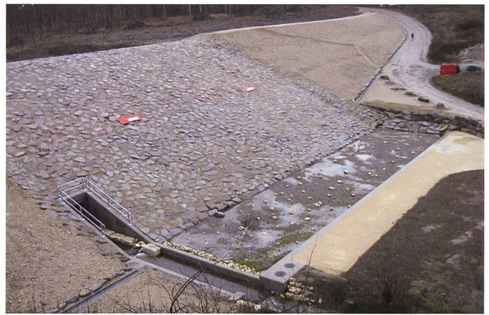
Bild 9. Hochwasserentlastung, Auslauf Durchlass und Tosbecken.
