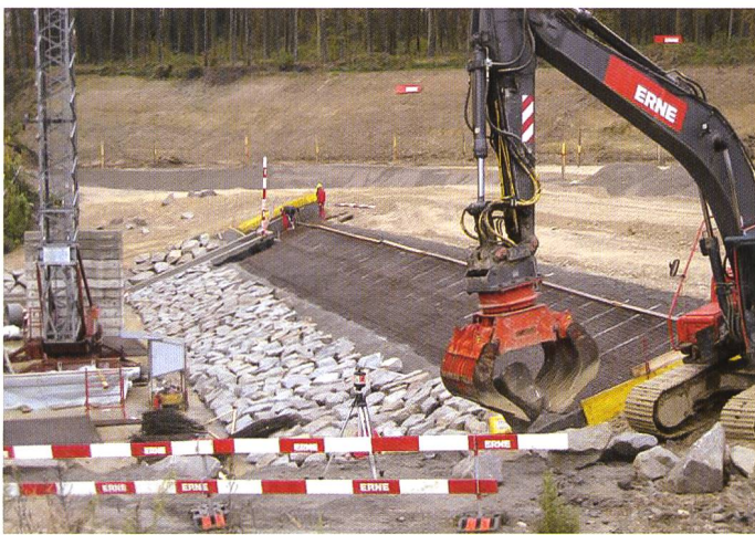
Bild 16. Versetzen von Bruchsteinen auf der Hochwasserentlastung.
