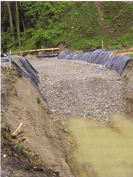
Bild 11. Materialersatz unter dem Durchlassbauwerk.
