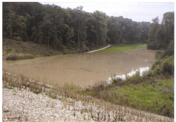
Bild 17. Ersteinstau des HWRB «Isigs Brüggli» am 14. September 2008, 9 Uhr.
