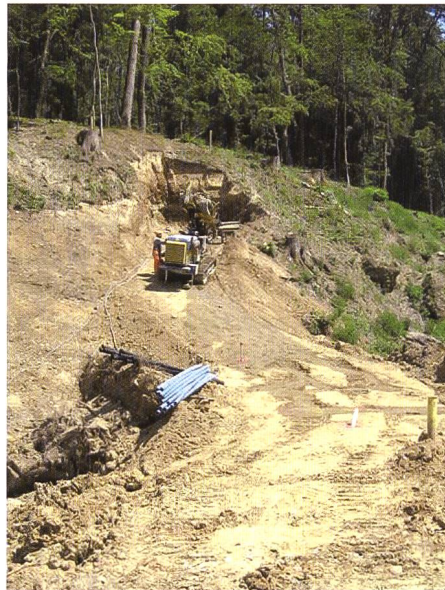
Bild 12. Injektionsbohrungen für Untergrundabdichtung.
