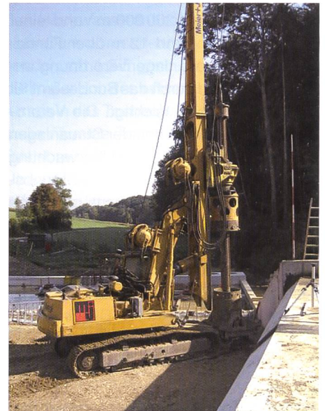
Bild 13. Filterbohrungen (d=80 cm) als Entlastungsfilter gegen Auftriebssicherheit.
