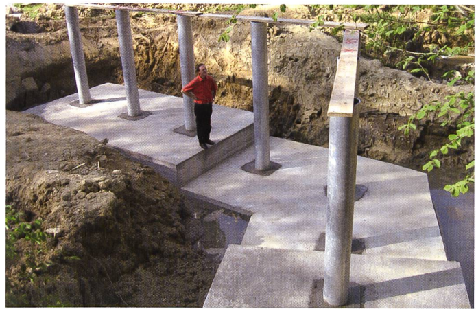
Bild 10. Bauzustand Grobrechen im Stauraum.
