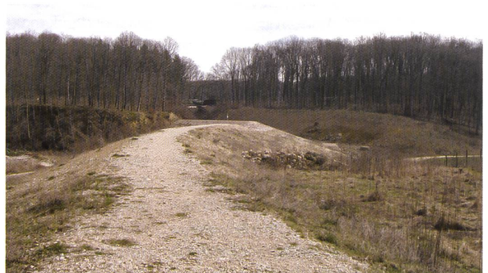
Bild 19. Sicht auf den Damm in östlicher Richtung Ende März 2010.
