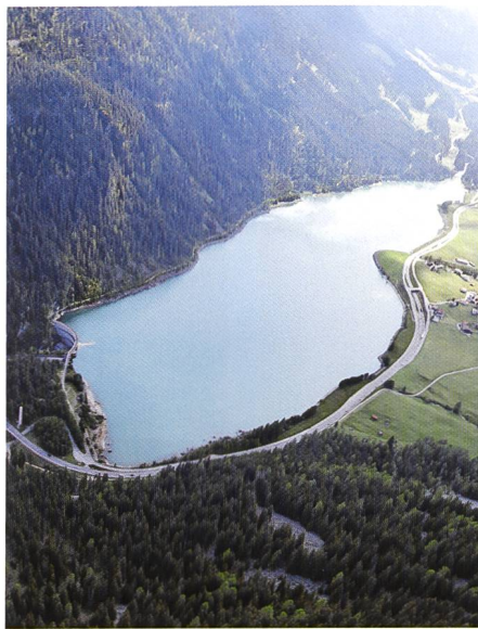
Bild 7. Sufers, Bogenmauer: Höhe 58.00 m, Kronenlänge 125.00 m, Nutzvolumen 16000000 m 3 .
