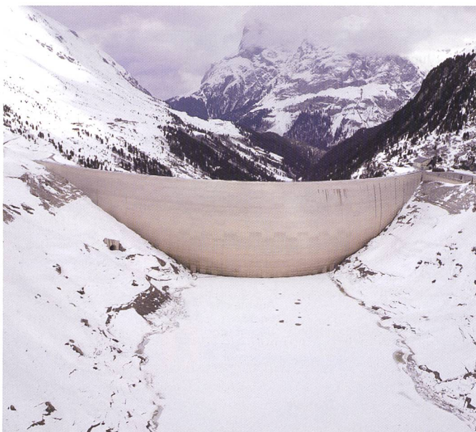
Bild 5. Staumauer Valle di Lei, Bogenmauer: Höhe 138.00 m, Kronenlänge 635.00 m, Nutzvolumen 197000000 m 3 .
