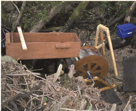
Bild 8.8. Das Rad wird installiert.
