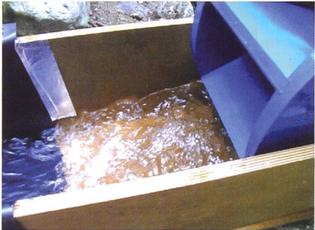
Bild 8.4. Bei grosser Belastung staut sich das Wasser im Kanal.
