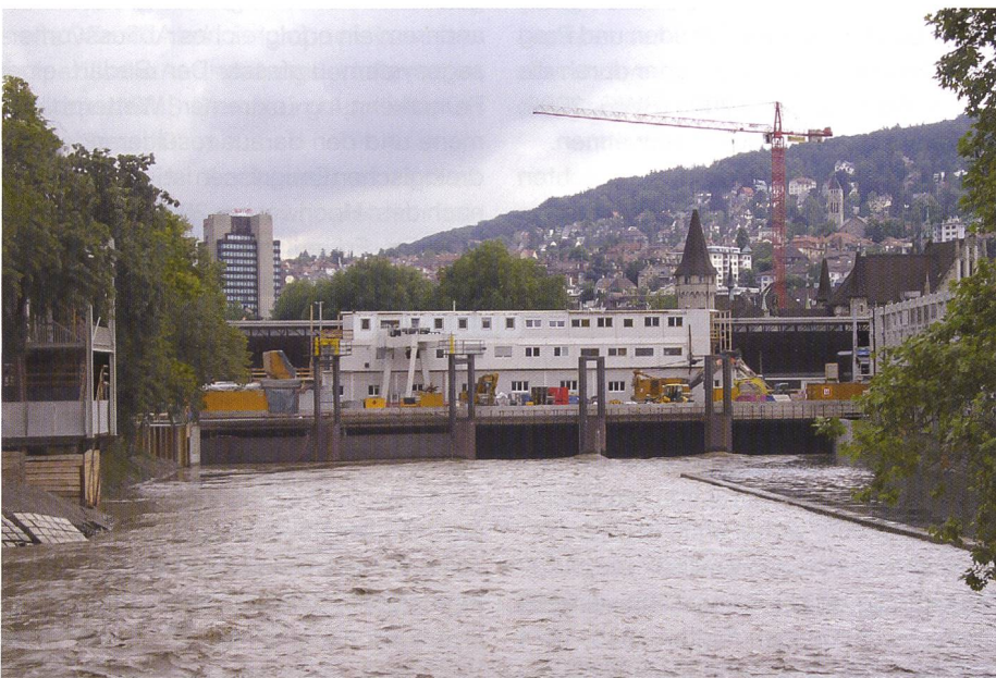
Bild 1. Die Sihl fliesst unter dem Hauptbahnhof Zürich hindurch. Zwei der insgesamt fünf Durchlässe waren (zum Zeitpunkt der Aufnahme) mit Flutoren geschlossen, welche im Falle einer Baustellenflutung geöffnet werden könnten. Aufnahmedatum: 14. Juli 2008; Abfluss rund 105 m 3 s -1 ; Aufnahme von Oberstrom.
