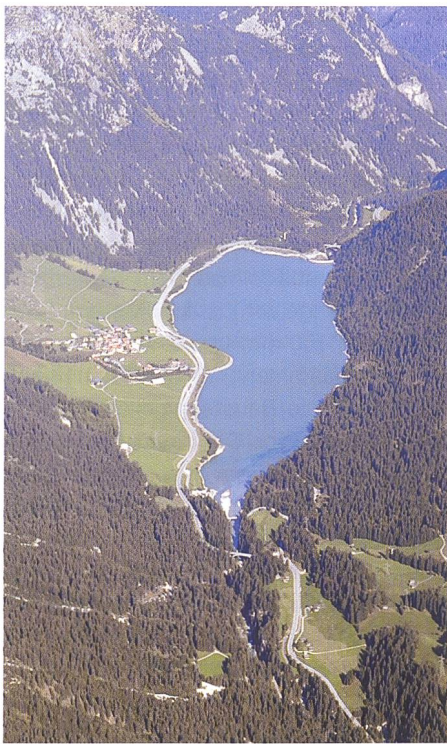
Stauanlage Sufers © khr.ch.
