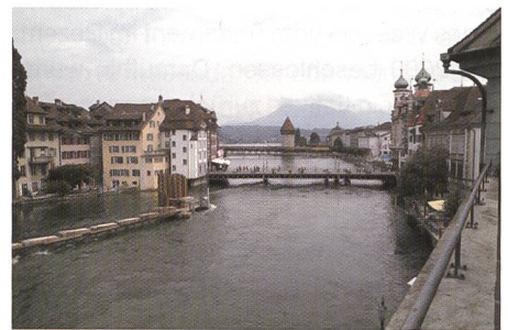
In Luzern hat die letzte Bauphase zum Ausbau der Reusswehranlage begonnen. Bilder: Kanton Luzern (vif) z.V.g.
