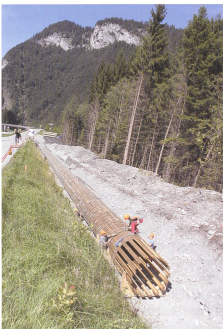
Bau der Holzleitung.
