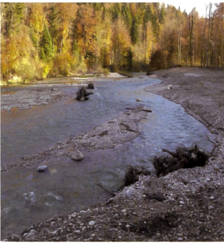
Bild 2. Tössabschnitt Mittlere Aue nach erfolgter Aufweitung.
