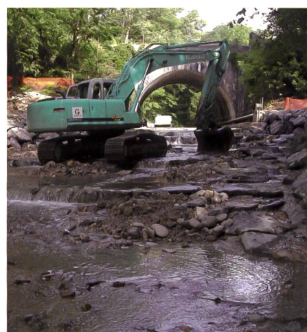
fig. 12. Réalisation d'une rampe à castor dans le cadre d'un aménagement piscicole sur le cours de la Promenthouse, coordonnées: 509 460/140 750.
