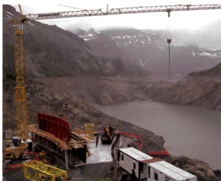
Das im Bau befindliche Pumpspeicherkraftwerks «Nant de Drance».
