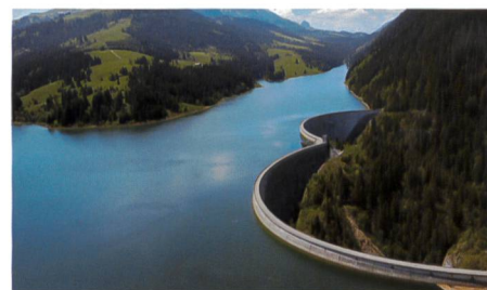
Bild: Bogenmauer Hongrin der FMHL.
