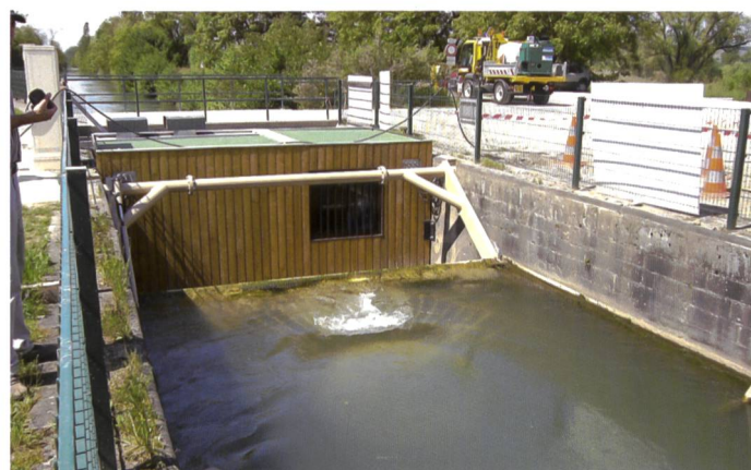
Bild 4. Ansicht des VLH-Konzepts an der Schleuse Nr. 2, Huningue bei Basel vom Oberwasser her. Von der gesamten Anlage ist nur der Schwenkarm der Maschine (weiss) sowie der Container (braun) mit den Nebenanlagen und Hilfsbetrieben sichtbar (hier direkt über dem Unterwasser und damit unter der Geländeoberfläche aufgestellt, da im Kanal kein Hochwasser zu befürchten ist).
