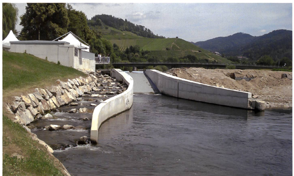
Bild 7. Bewegliches Kraftwerk an der Kinzig bei Gengenbach (D) vom Unterwasser her gesehen: rechts der Trog mit dem Krafthausgehäuse, links die Fischaufstiegshilfe in Form eines Rauherinne-Beckenpasses.
