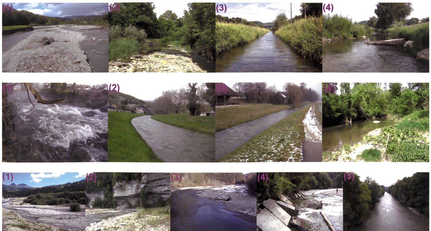
Bild 3. Aufnahmen der Untersuchungsabschnitte. Bünz (oben): (1) durch Jahrhunderthochwasser 1999 geformtes pendelndes System («Bünzau»), (2) naturbelassen pendelnd, (3) kanalisiert, (4) revitalisiert.
