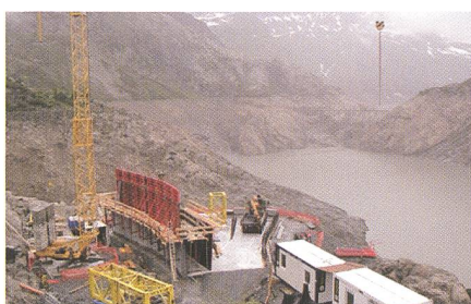
Bild 1. Fertigung des Ein-/Auslaufbauwerkes am Ufer (Foto: SWV/Pfa).
