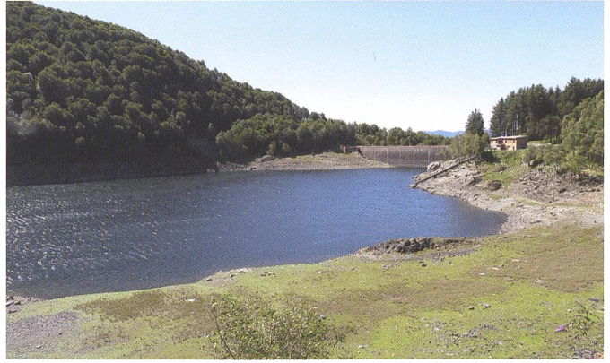
Bild 4. Lago Delio mit Staumauer Nord (Foto wikimedia).
