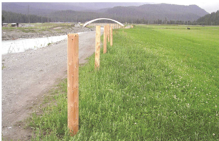
Bild 1. Flach angeordnete Böschung des Hochwasserschutzdamms am neuen Flaz bei Samaden.
