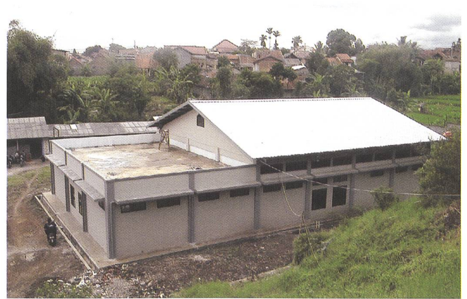
Bild 2. Das HYCOM, Kompetenzzentrum für Kleinwasserkraft, in Bandung ist fertig gestellt.
