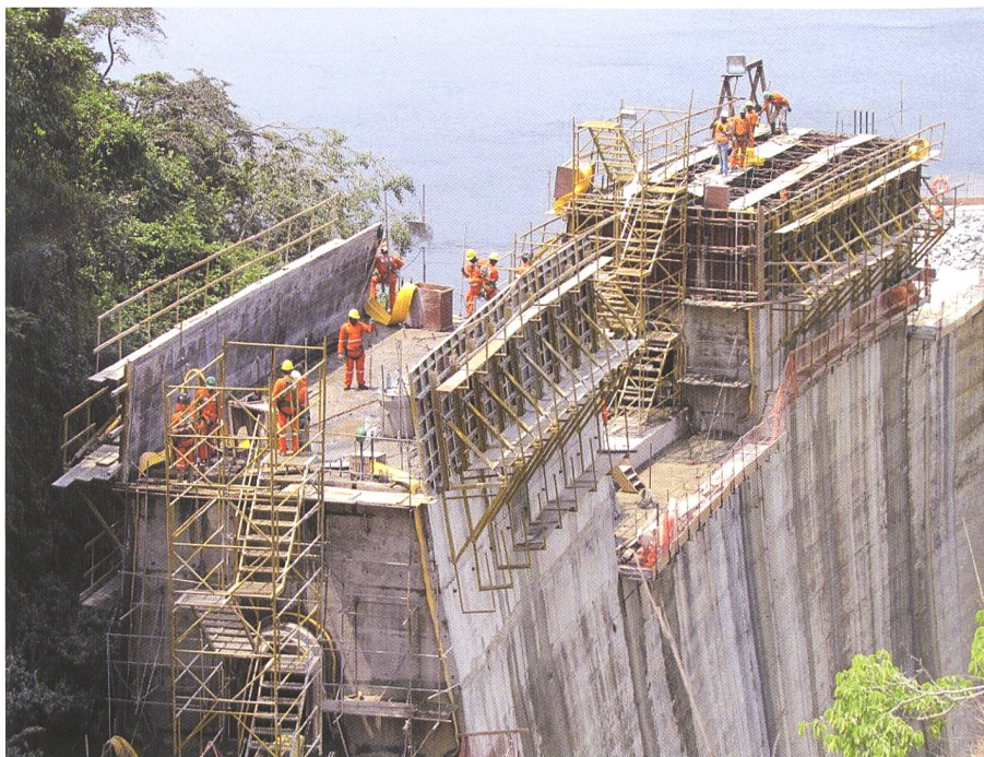
Figure 6. Cambambe, travaux de surélévation en cours sur la rive droite (août 2012).
