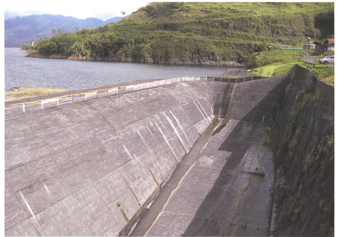
Bild 19. Fortuna-Damm: Neue Hochwasserentlastung am linken Ufer.
