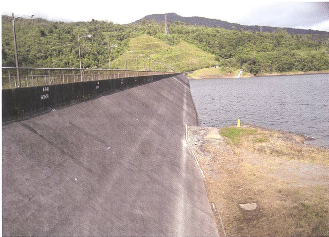
Bild 18. Fortuna-Damm: Erhöhter Teil mit Spritzbetonoberfläche.
