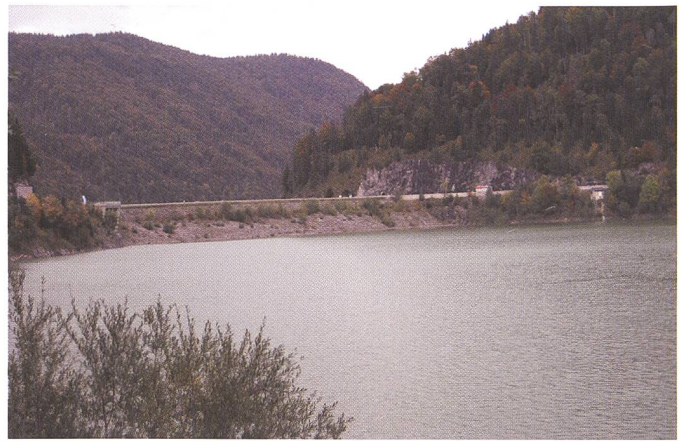
Bild 6. Sylvenstein-Damm mit Speichersee. Die steile Wand am rechten Widerlager ist gut erkennbar.
