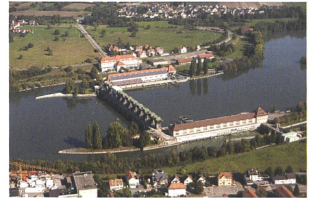
Luftaufnahmen Zwillingskraftwerk Augst-Wyhlen: Das zur Energiedienst-Gruppe gehörende Rheinkraftwerk in Wyhlen ist Teil des Zwillingskraftwerks Augst-Wyhlen und wurde in den Jahren 1908 bis 1912 gleichzeitig mit dem auf der Schweizer Seite liegenden Kraftwerk Augst errichtet. Ein gemeinsam bewirtschaftetes Stauwehr verbindet die beiden Kraftwerke, die seit Betriebsstart 1912 die Energie des Rheinwassers zu gleichen Teilen nutzen. (Quelle: Energiedienst/E.Brunner)
