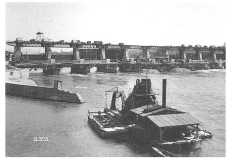
Bau Stauwehr/April 1912: Im Gegensatz zu den beiden Maschinenhäusern wurde das 212 Meter lange Stauwehr gemeinsam errichtet. (Quelle: Energiedienst)
