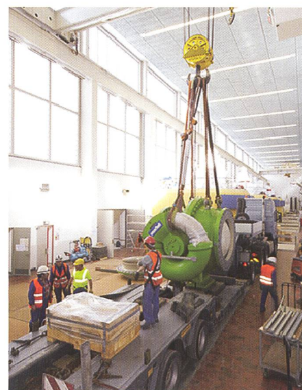
Bild 2. Viele Hände helfen mit, einen Kugelschieber in der Zentrale Sils zu entladen.
