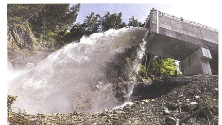
Bild 4. Demonstration des Auslaufbauwerks mit 20 m 3 /s, maximal sind 170 m 3 /s möglich. (Bild: Jano Felice Pajarola)
