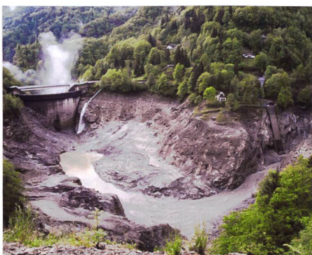
Foto 4. Spurgo del bacino di Palagnedra A novembre 2014, la visita di cantiere per la sistemazione e la rivitalizzazione del torrente Roncaglia a Novazzano si è svolta sotto la pioggia (foto 5).
