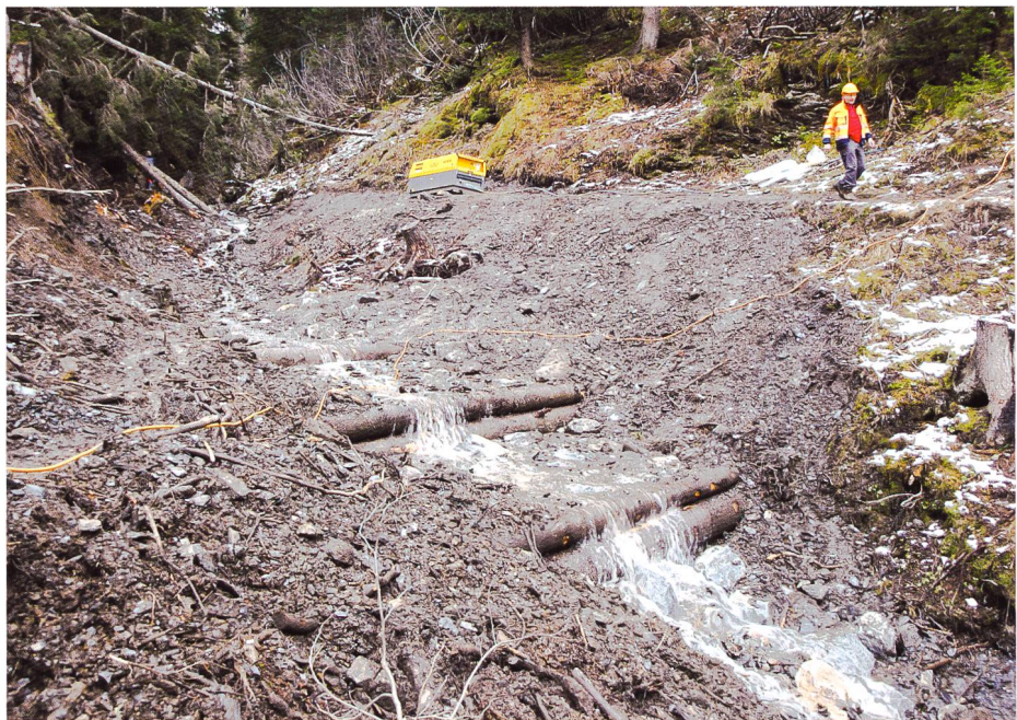
Bild 2. Der Moosbach im November 2013, nach dem Abbruch der Wasserfassung.
