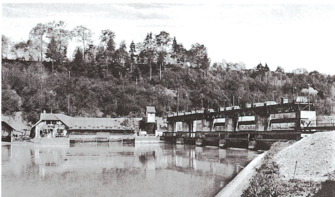
Bild 1. Stauwehr Niederried (Foto: F. Pauli, Detligen).
