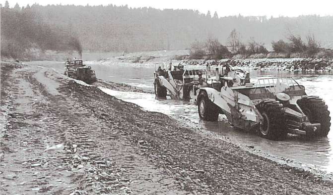
Bild 7. Kanalisierung der Aare mit schwerem Gerät im ehemaligen Auengebiet (Foto: BKW Energie AG).
