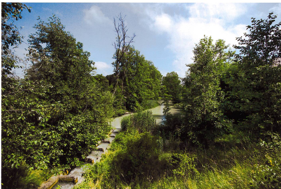
Bild 13. Bibergängiger Fischpass ab der Alten Aare (Foto: BKW Energie AG).
