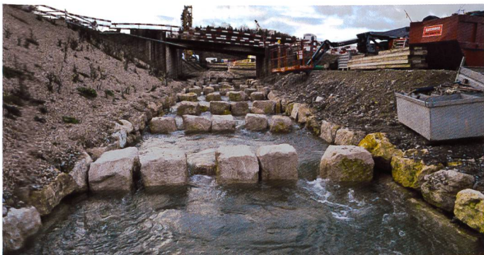
Bild 5. Umgehungsgerinne kurz nach Inbetriebnahme im Dezember 2014 (Foto: Thomas Richli).
