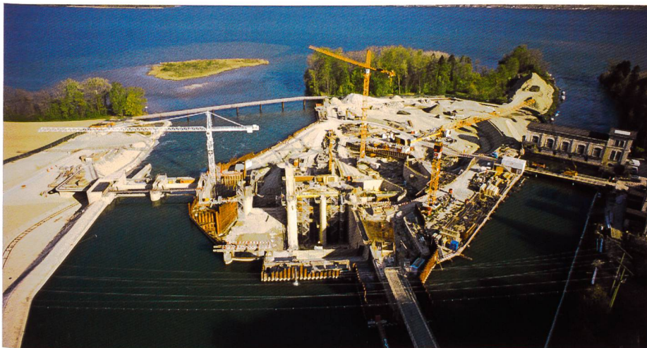
Bild 11. Sicht auf Baustelle (Stand April 2014) (Foto: Thomas Richli).
