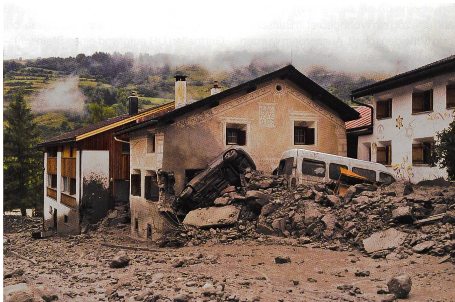
Bild 8. Ein Murgang aus dem Val Triazza beschädigte am 22. Juli in der Fraktion Pradella der Gemeinde Scuol GR mehrere Gebäude (Foto: Amt für Wald und Naturgefahren Graubünden).
