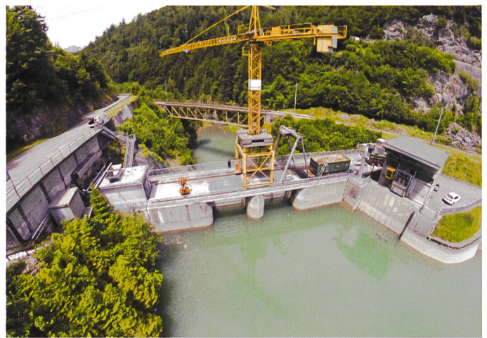
Figure 2. Vue vers l'aval du barrage de Rossinière.
