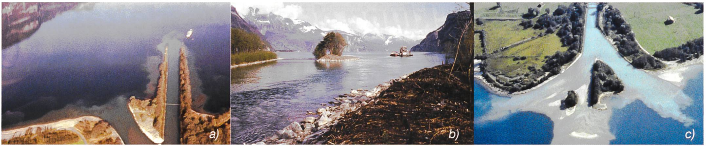
Bild 3. Öffnung des «linken Arms» 1989 (a), Öffnung des «rechten Arms» (b), erste Entwicklung bis 1992 (c) (Aufnahmen VAW, M. Jäggi, O. Lang, Uster).
