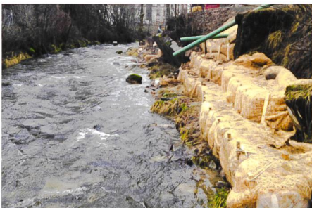
Bild 1. Howolis-Q-Faschine: Sicherung der Uferverbauung mit Howolis Q Faschinen (die grüne Rohre dienen als Provisorium für den Wasserablauf).
