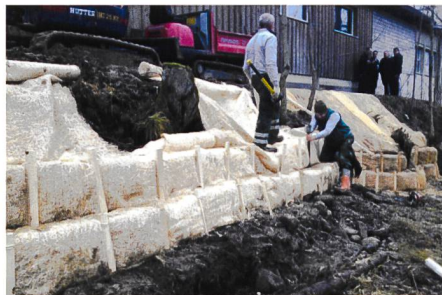
Bilder 2,3,4. Howolis-Q-Faschine: Verlegen der Q-Faschinen, Verpflockung und Befestigung der Faschine entlang des Ufers.
