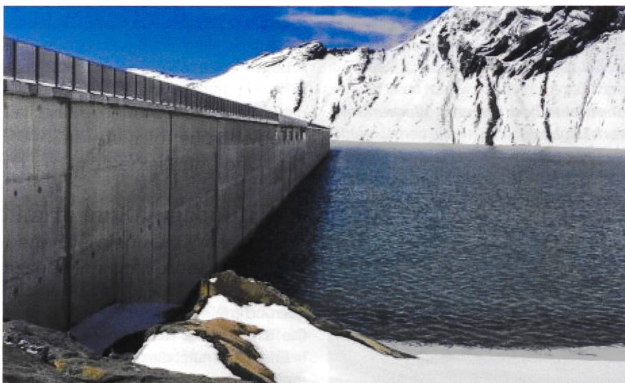
Bild 2. Teileinstau bei der neuen Talsperre Muttsee (Quelle: Axpö).
