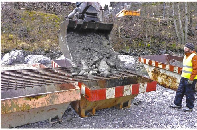
**Bild 8. Siebanalyse des Untergrundmaterials (Simme, Bäuerleidli), Aussieben der groben Komponenten.**
