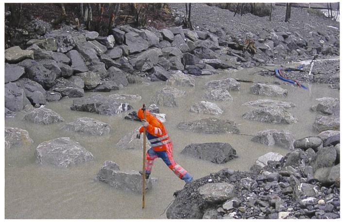
**Bild 9. Kontrolle der Positionierung der Blöcke (Simme, Latterbach).**
