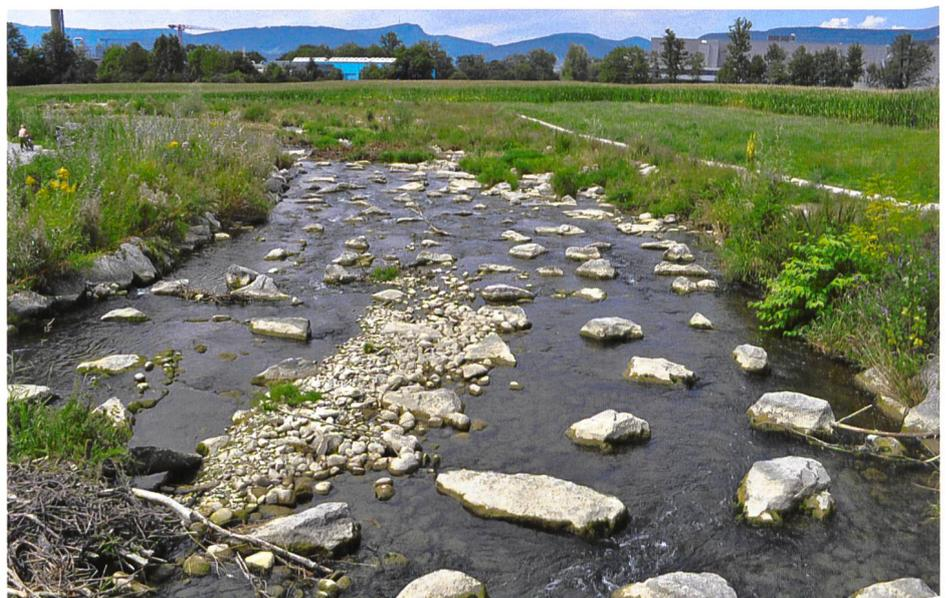
**Bild 1. Aufgelöste unstrukturierte Blockrampe (UBR) an der Wyna (Kanton AG) mit einem spezifischen Abfluss  $q \approx 0.03 \text{ m}^3/(\text{sm})$ , entspricht in etwa einem Niederwasserabfluss  $Q_{325}$  (Blick in Fließrichtung).**
