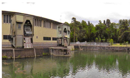
Die ausgewählten Projektstandorte KW Bannwil (oben) und KW Wildeggen-Brugg (unten) (Fotos: BKW und Axpo).
