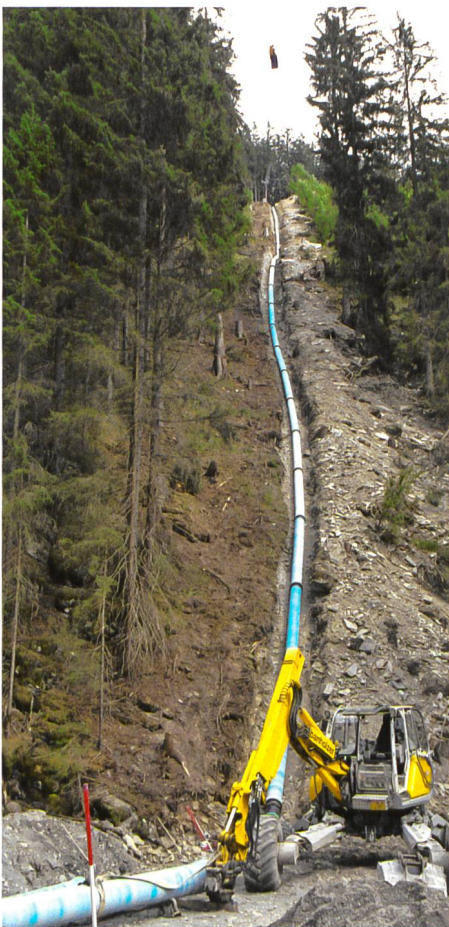
Bild 18. Verlegte Druckleitung DN400 im Steilhang Albrist (Aug. 2015).
