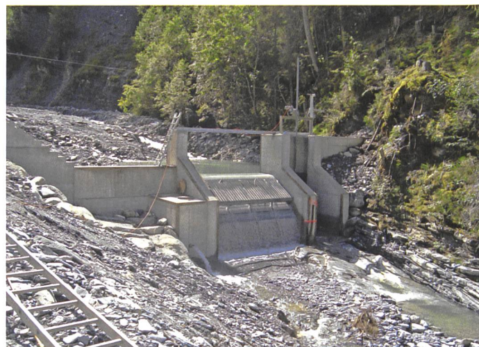
Bild 7. Fassung Albrist in Betrieb (Aug. 2015).
