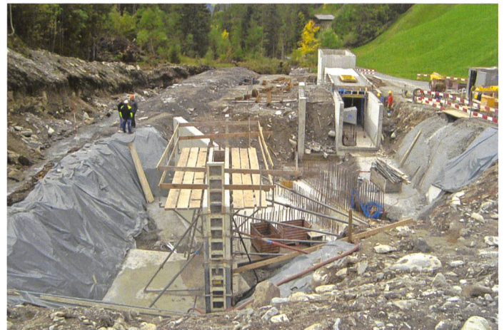
Bild 14. Fassung Fermelbach in Fliessrichtung, links Umleitung des Baches und rechts Sandfang (Sept. 2015).
