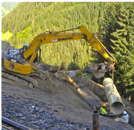
Bild 22. Verlegung Druckleitung GFK DN1000 im steilen Gelände mit eigens konstruiertem Fahrgestell (Sept. 2014).
