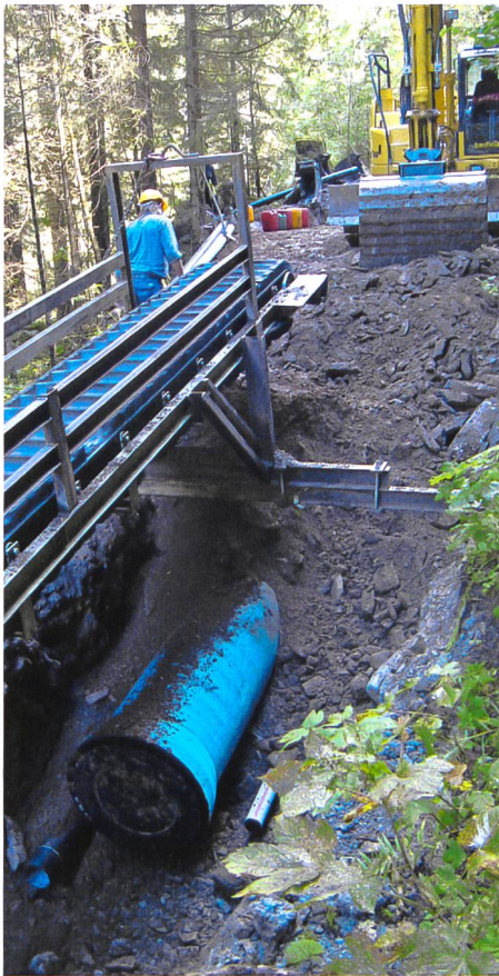
Bild 17. Bau der Druckleitung DN600 im alten Fermelweg; der Aushub wird direkt wieder für die Hinterfüllung des vorher verlegten Rohres benutzt (Aug. 2014).
