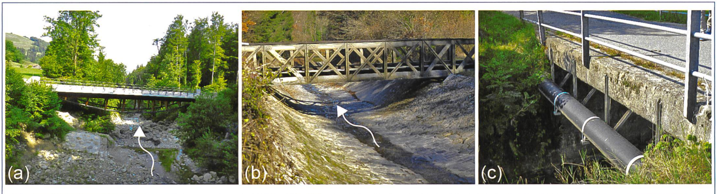
Bild 6. Beispiele für Brücken im Projektperimeter mit einer ungünstigen Geometrie: (a) Unterzugkonstruktion der Hergiswaldbrücke II, (b) Fachwerkkonstruktion der SBB Brücke, (c) Werkleitung an der Fischereibachbrücke.
