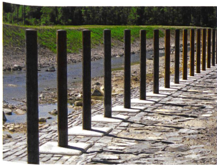
Bild 13. Die Rechenstäbe aus Stahl sind ausbetoniert und oben mit einer Stahlkappe geschlossen. Die leicht vorstehenden Köcherfundamente zeigen die Verankerung der Rechenstäbe im Fundament. Die Stäbe des Querrechens stehen auf Terrainhöhe des Rückhalteriums.
