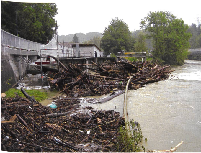
Bild 5. Schwemmholzablagerung nach dem Hochwasser von 2005 bei Langnau am Albis (Blick in Fliessrichtung).
