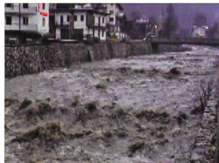
Bild 3. Kanalisierter und mittels Traversen stabilisierter Abschnitt des Gebirgsbachs Maè bei Forno di Zoldo (Italien) während des Hochwassers im November 2002 (Comiti und Lenzi, 2006).
