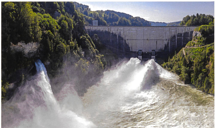
Bild 3. Künstliches Hochwasser an der Saane unterhalb der Staumauer Rossens vom 14. und 15. September 2016. Bild: Forschungsgruppe Ökohydrologie ZHAW.
