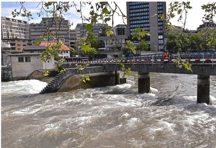
Bild 2. Das abgelegte und für zwei Stunden beinahe frei durchströmte Platzspitzwehr, 230 m 3 /s (Quelle AWEL).
