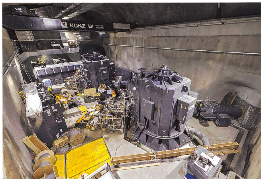
Bild 6. Montage der Maschinengruppen.
