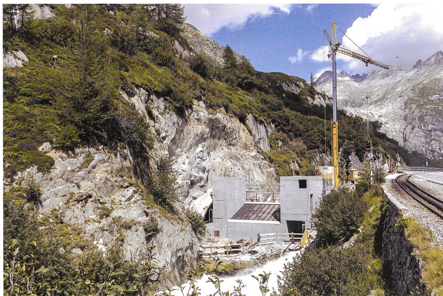
Bild 4. Bau des Tirolerwehrs.
