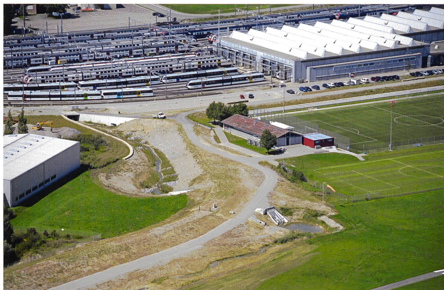
Bild 4. Durchlass mit Grobrechen nach Fertigstellung, Blick Richtung Norden. Der Rückhalteraum befindet sich rechts.
