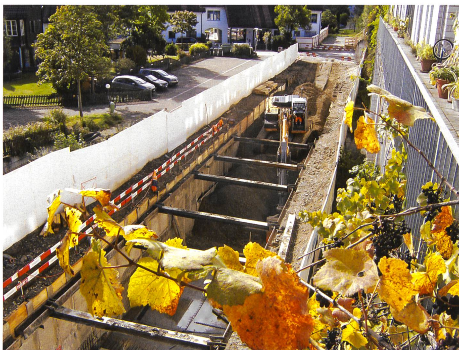
Bild 13. Baugrube Zuflusskanal, während den Aushubarbeiten.
