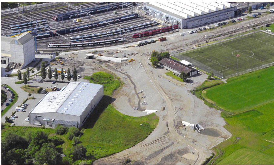
Bild 5. Dammschüttung im Bereich Durchlass kurz vor Vollendung, Blick Richtung Norden. Der Rückhalteraum befindet sich rechts.
