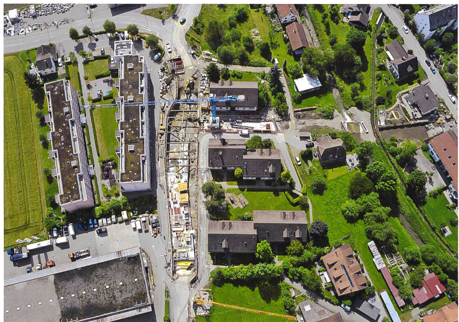
Bild 14. Baugrube Trennungsbauwerk, Fliessrichtung im Hochwasserfall von unten nach oben. Beim verschiebbaren blauen Baustellenkran zweigt der Zuflusskanal nach rechts Richtung Rückhalteraum ab und unterquert anschliessend die Eulach.
