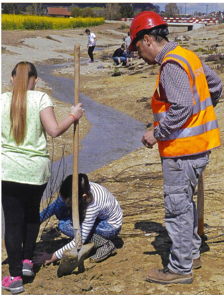
Bild 7. Bei der Renaturierung haben Schulklassen aus dem Quartier kräftig mitangepackt.
