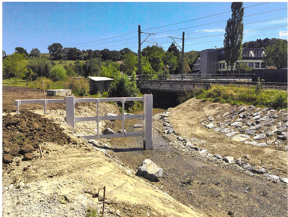
Bild 15. Unterer Schwemmholzrechen in der Linkskurve der Eulach, Blick gegen Fliessrichtung.
