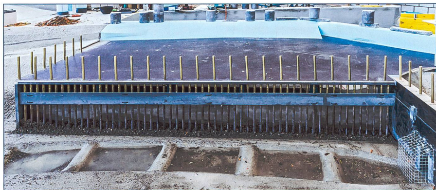
Bild 12. Ansicht des adaptierten Einlaufbauwerks der Variante «Rechen mit Blende» – LSA = 0.3 m, Stabdicke = 0.06 m.
