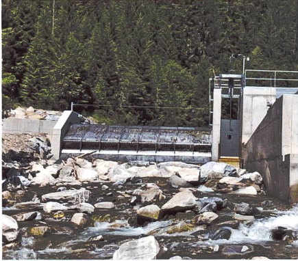
Kraftwerk Schanielabach im Prättigau (Foto: Gemeinde Luzein).
