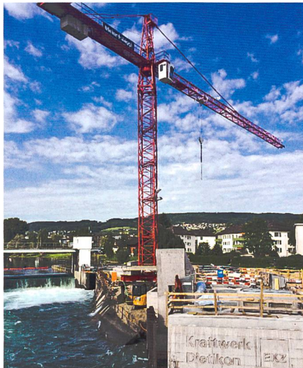
Kraftwerk Dietikon in der Umbauphase im Juni 2019 (Foto: Pfa)
