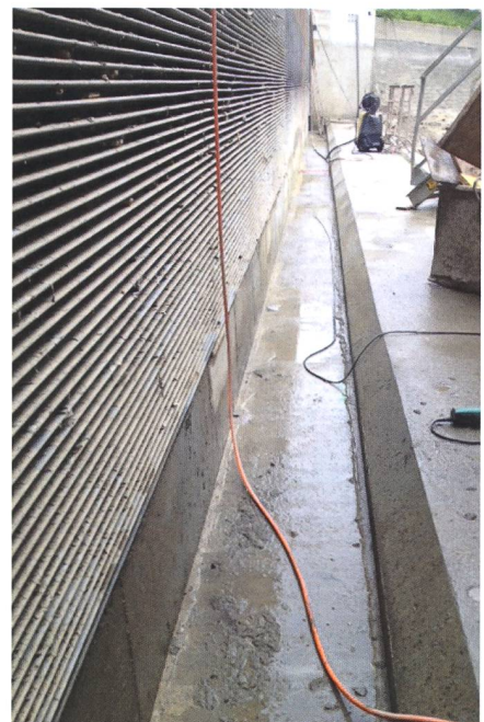
Abbildung 1: Ansicht Fischleitrechen im Bau.
