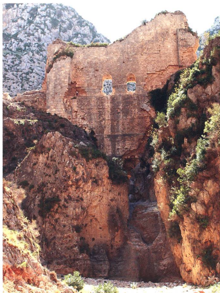
Bild 2: Das «Eiserne Tor» von Antiochia, unmittelbar über einer 35m hohen Talstufe. In der Mitte die beiden Hochwasserüberläufe.
