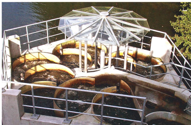
Figure 5: Passe à poissons en hélice, Schwentine/Schleswig-Holstein (photos: E. Kuberski).
