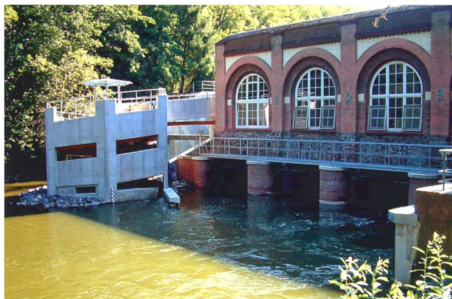
Figure 5: Passe à poissons en hélice, Schwentine/Schleswig-Holstein (photos: E. Kuberski).
