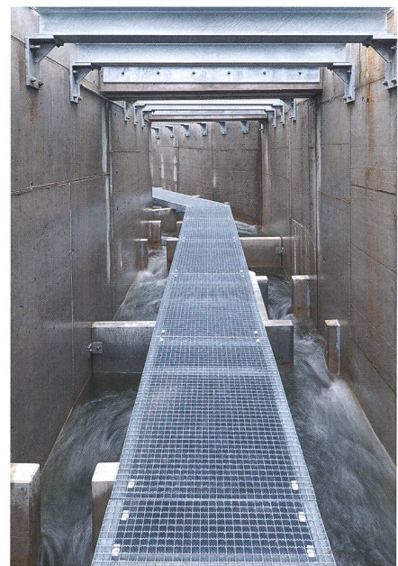
Bild 3: enature®-Fischaufstiegshilfe beim Dotierkraftwerk (Foto: EKZ).
