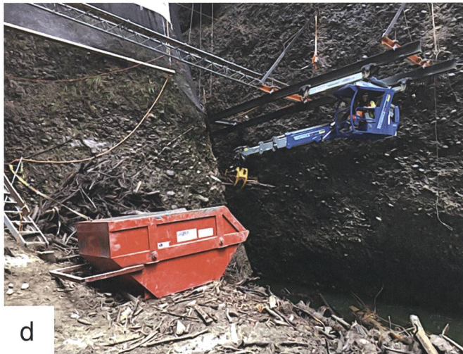
Bild 11: Impressionen der Baustelle, a) und b) Installationsplatz Jodershubel mit Transportseilbahn, c) Gerüstturm, d) Schienenkran beim Beladen der Mulden, e) beidseitig verankerte Schienen in der verwundenen Schlucht.
