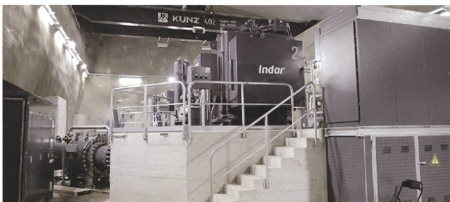
**Bild 1:** Maschinenraum des Kleinwasserkraftwerks in Oberwald: Die Turbinen mit 2 x 7,5 MW Leistung sind auf die Maximalproduktion im Sommer ausgelegt. Zum Vergleich: Die fünf Windräder, die im Herbst 2020 auf dem Gotthard in Betrieb genommen wurden, haben eine Nennleistung von 5 x 2,35 MW. Foto: FMV.
