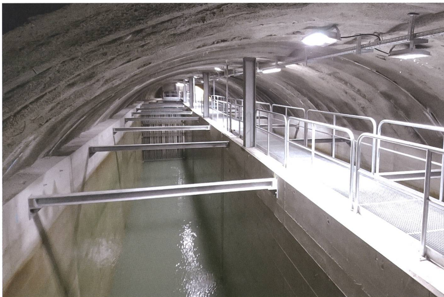
Bild 4: Die Entsanderkaverne, zur Hälfte entleert. Foto: FMV.
