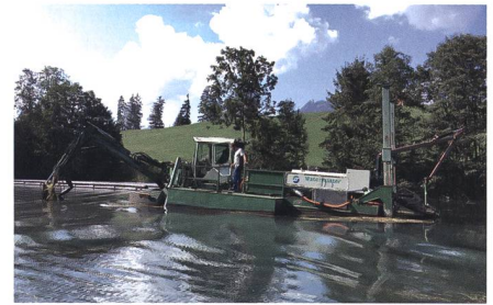
Baggerung am Ägelsee. Foto: BKW.
