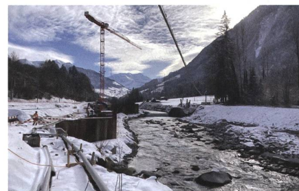
Baustelle Kraftwerk Augand an der Kander. Foto: BKW.
