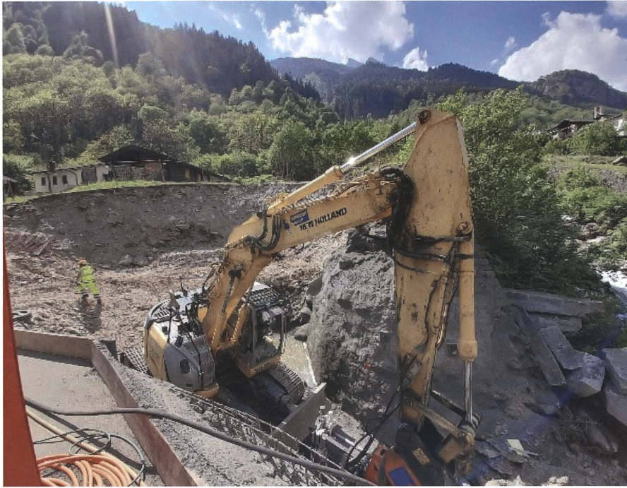
Bau Wasserkraftwerk Arvigo in Calanca. Bild: BKW.
