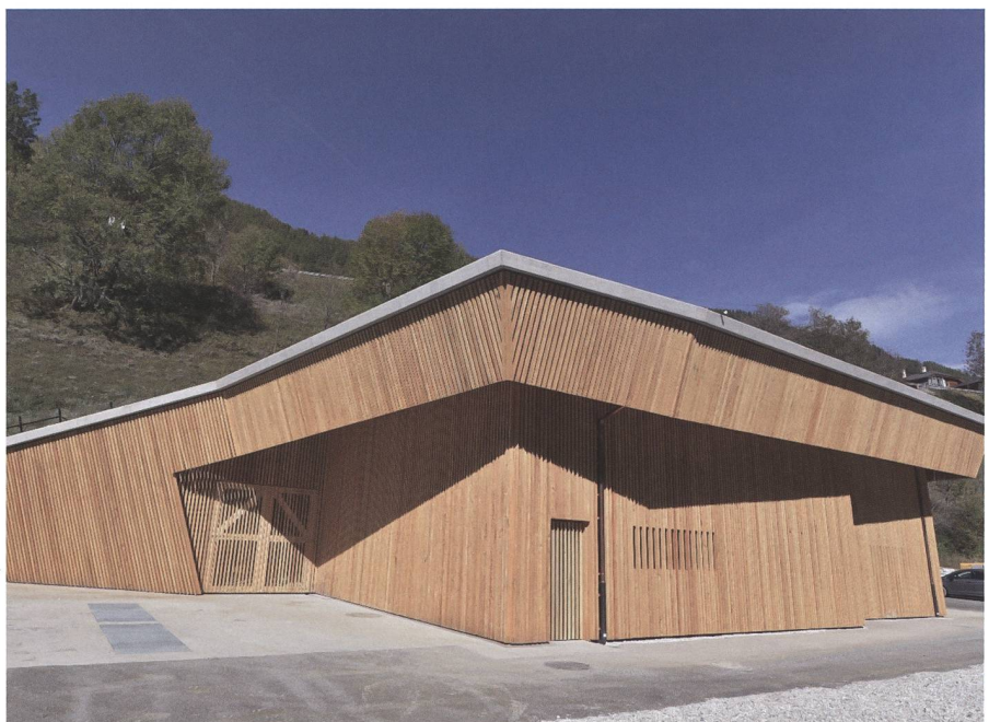
Die Zentrale des Kraftwerks Wiler-Kippel (Bild: BKW).
