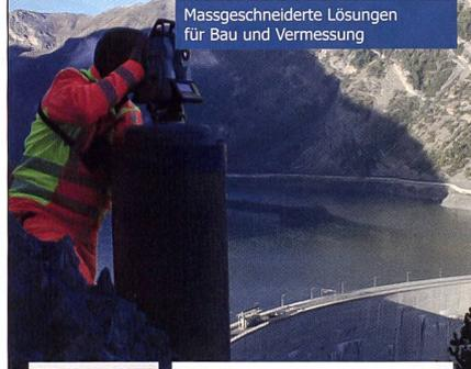
Präzisions-Geodäsie zur Überwachung von Stauanlagen, Druckleitungen und Wasserkraftwerken
