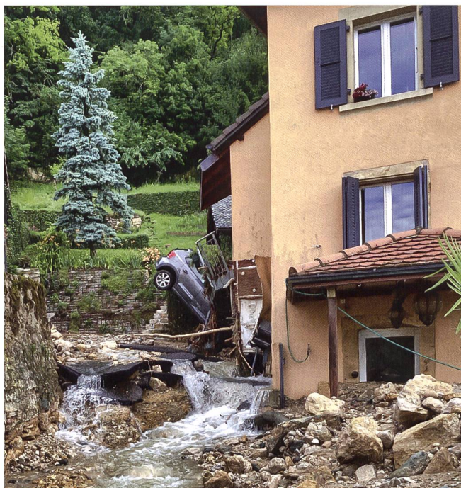
Bild 7: Nach einem intensiven Gewitterregen trat am Abend des 22. Juni 2021 in Cressier NE der Bach Le Ruhaut über die Ufer, überflutete weite Bereiche des Dorfes und lagerte grobes Geschiebe, Schwemmholz und Feinmaterial ab (Foto: Christophe Déneraud).
